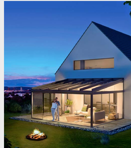
Glasdach mit Seitenverglasung
